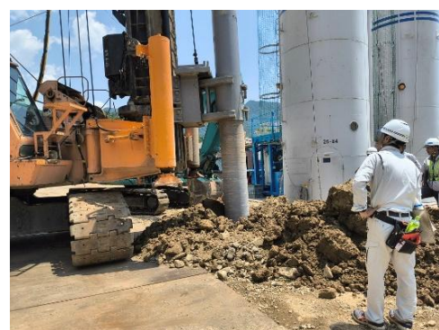
深度約 7.5M まで掘削
