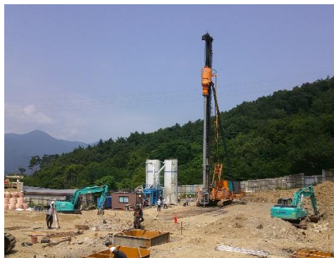
東から撮影 掘削機 高さ約30M
