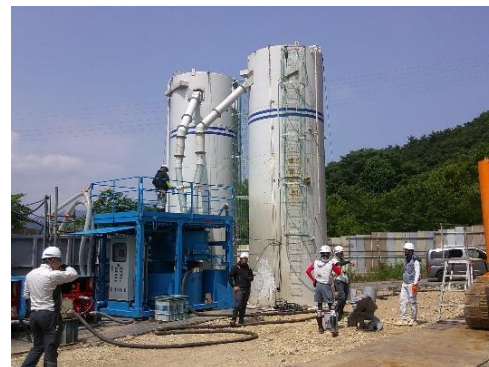
柱状改良用セメントサイロ
