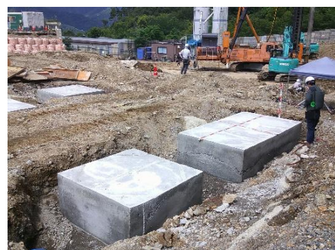
C エリア 表層改良工事(ラップルコンクリート)
