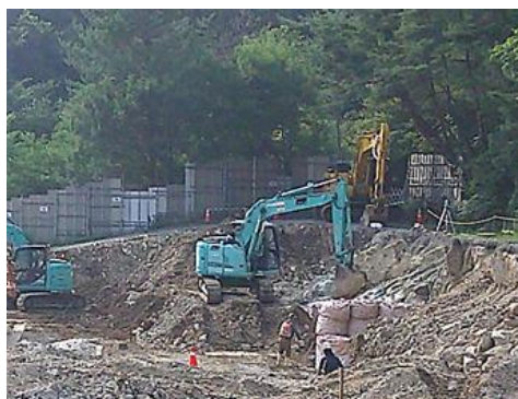
B エリア 岩盤掘削工事
