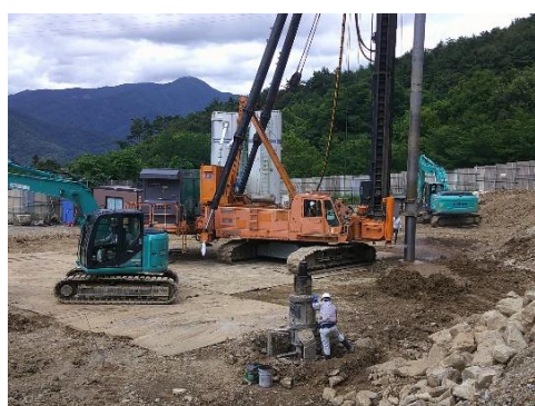
A エリア 大型掘削機 柱状改良工事
