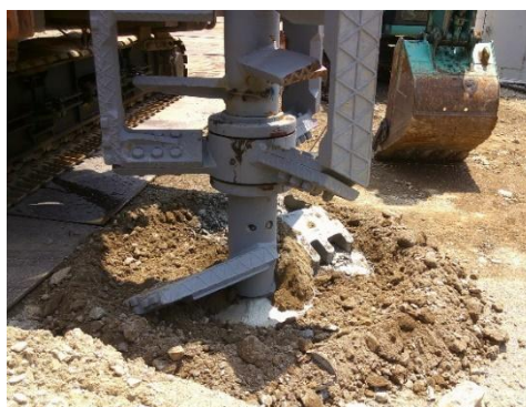
試験掘削 攪拌(掘削)径 1.6M
