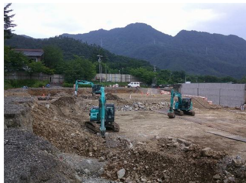
工事着工前 A・B 手前 C 奥エリア
